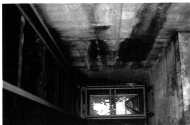
Photo 5 : Cuve de l'ascenseur de Poutès en phase de remontée.
