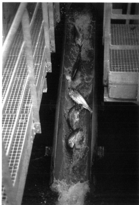
Photo 9 : Déversement des poissons dans le canal amont de l'ascenseur de Golfech.
